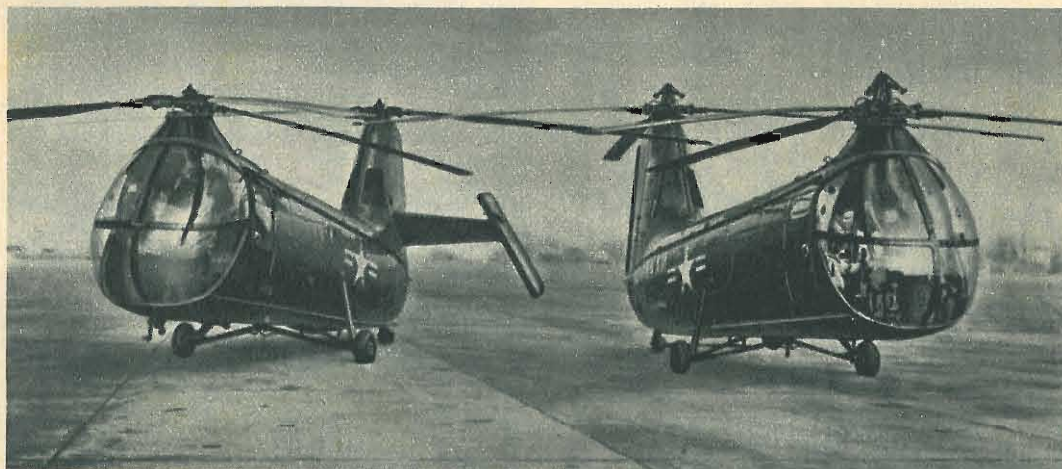
● Il pilotaggio automatico risolve sugli elicotteri il problema della guida nel volo cieco. Sul Pia-secki sono stati così soppressi gli stabilizzatori verticali (che sussistono nel modello di destra).
