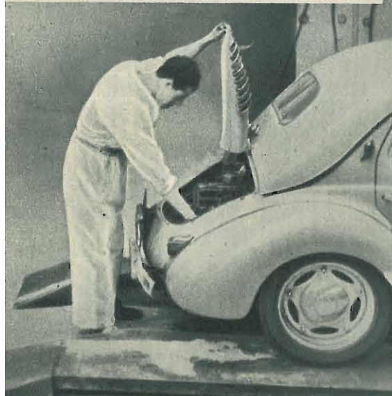
● Ingrassare e polverizzare proteggono le molle a spirale che sono molto esposte ad usura.
