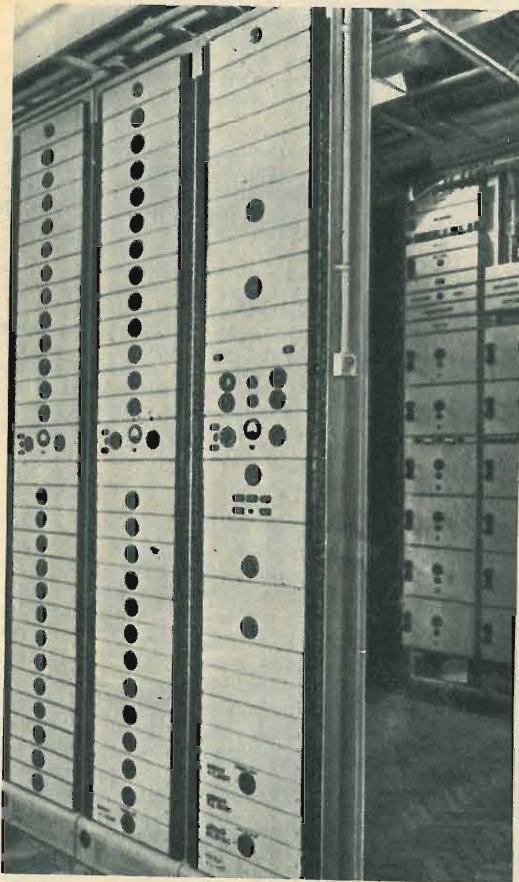
Fig. 8. — Vista d'insieme (a partire da sinistra) di tre sezioni di apparecchiature modem di canale e di una sezione di generazione delle frequenze portanti di canale nel sistema Standard-Face. Ogni sezione completa contiene 24 unità modem di canale e cioè tutte le apparecchiature occorrenti per la formazione di due degli 80 gruppi.
