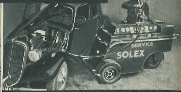
● In alcune stazioni di servizio un banco di prova mobile controlla la carburazione e l'accensione.
