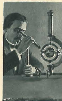
LEON FOUCAULT, creatore del giroscopio, dimostrava nel 1852 con questo apparecchio la rotazione della Terra.
